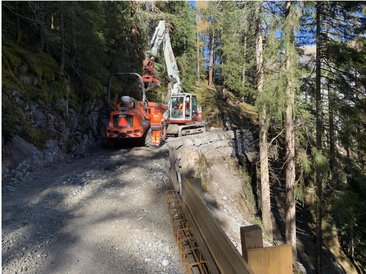
Erstellung von Blocksteinmauer und Kordon unter engen Platzverhältnissen (Foto: Urs Fliri)
