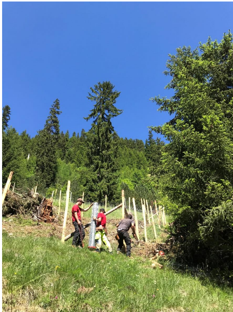
Forstwarte beim Bau des Wildschutzzauns 97 oberhalb Stuls (Foto: Ben Turner)
