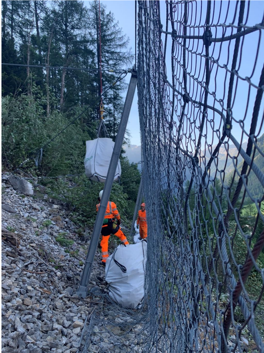
Räumung der Steinschlagnetze Gatscheras, Unterhalt (Foto: Urs Fliri)
