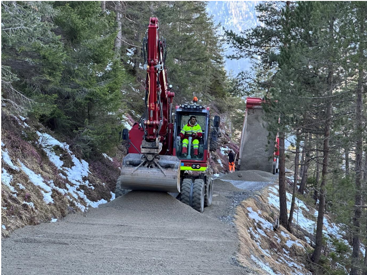
Einbringen der Verschleisschicht auf dem untersten Abschnitt (Foto: Carlo Guetg)
