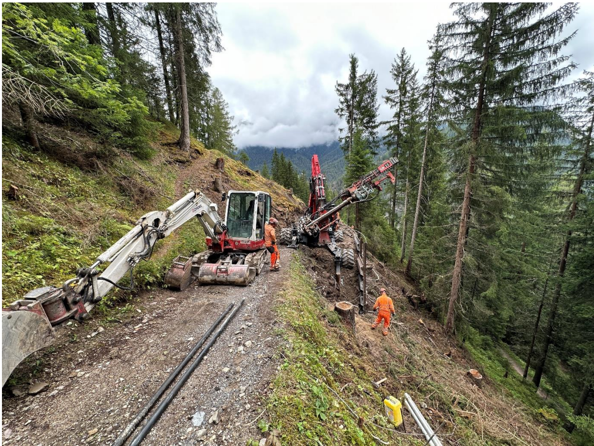
talseitige Verbreiterung des Waldweges mit verankerten Stahlwänden (Foto: Carlo Guetg)
