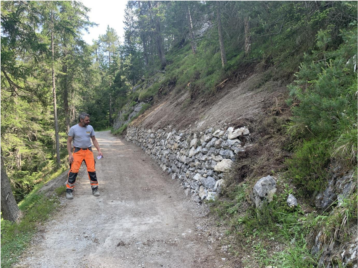
bergseitiges Blendenmauerwerk nach der Erstellung (Foto: Urs Fliri)
