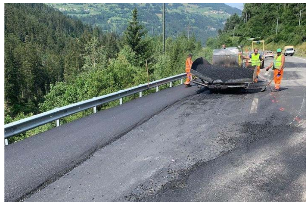
Reparaturarbeiten an der Landwasserstrasse 2019. Bild: Gion Hagmann, TBA Graubünden
