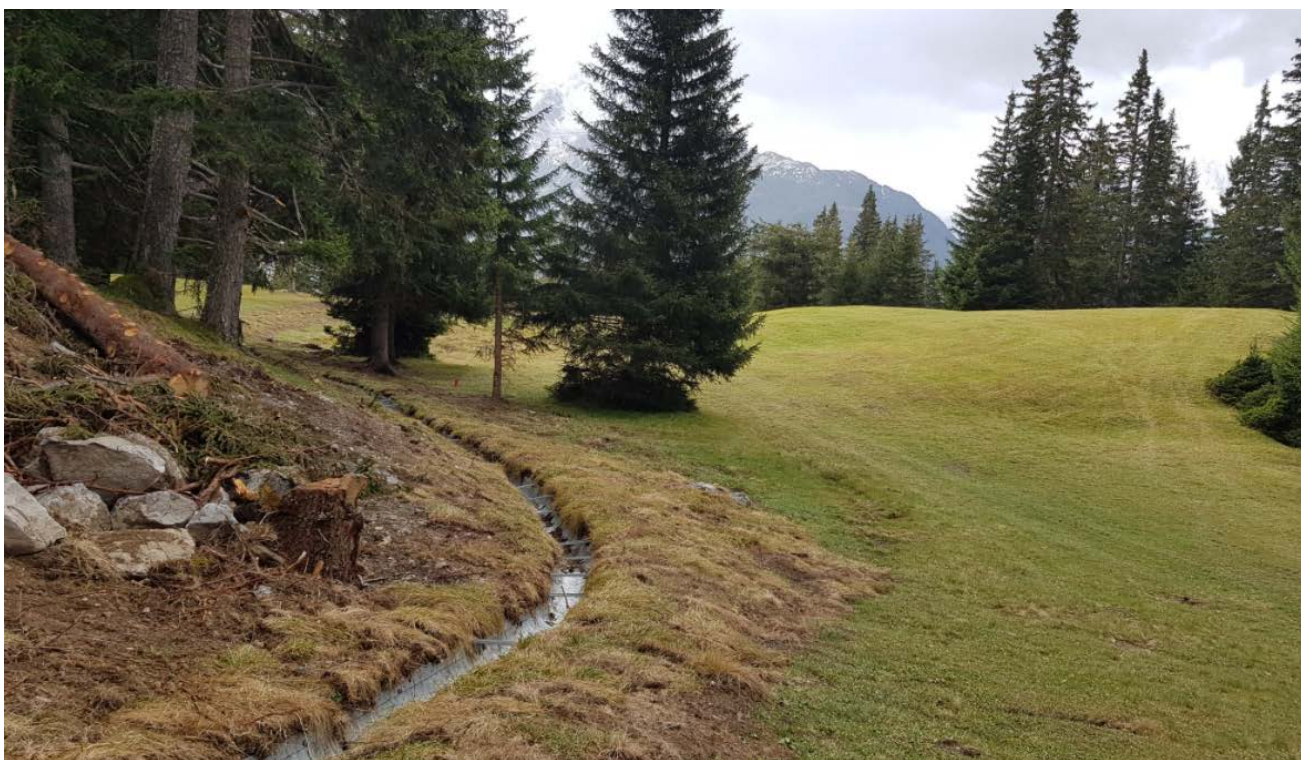
Einer der bereits erneuerten Kanäle im Gebiet Propissi. (Bild: Reto Crameri/twitter.com)
