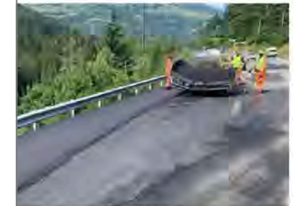
Arbeiten an der Landwasserstrasse 2019. Gion Hagmann, TBA Graubünden
