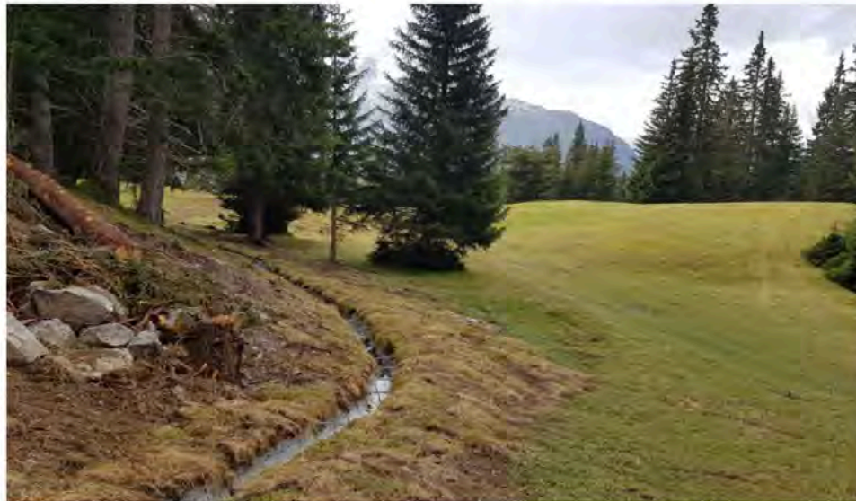
Einer der bereits erneuerten Kanäle im Gebiet Propissi. (Bild: Reto Cramer/twitter.com)
