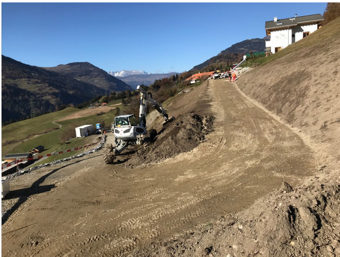
Die neu gebaute Abzweigung in die Voia Salera in Vazerol. Die Quartierstrasse liegt nun vollständig ausserhalb der Rutschung und dürfte von schwereren Schäden verschon bleiben. Bild: gartmann.biz
