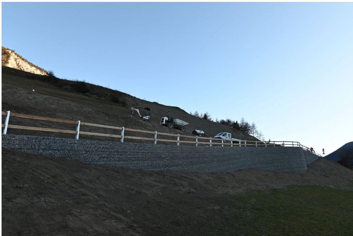
Für die neue Abzweigung in die Voia Salera musste eine Stützmauer erstellt werden.
