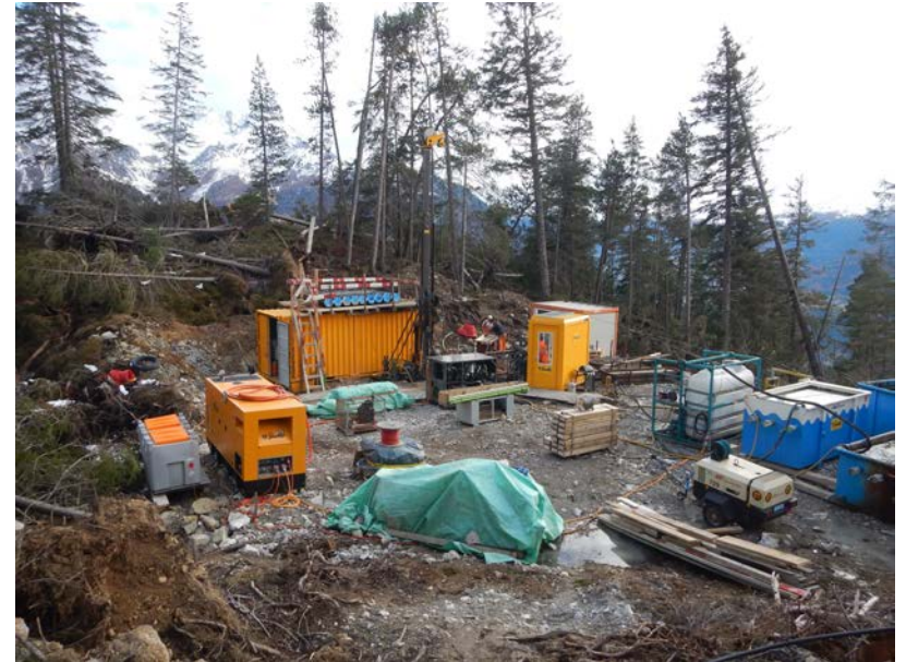
Bohrarbeiten am 3. November 2020
