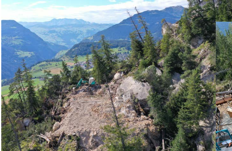
Einrichten Bohrplatz am 28.8.2020
