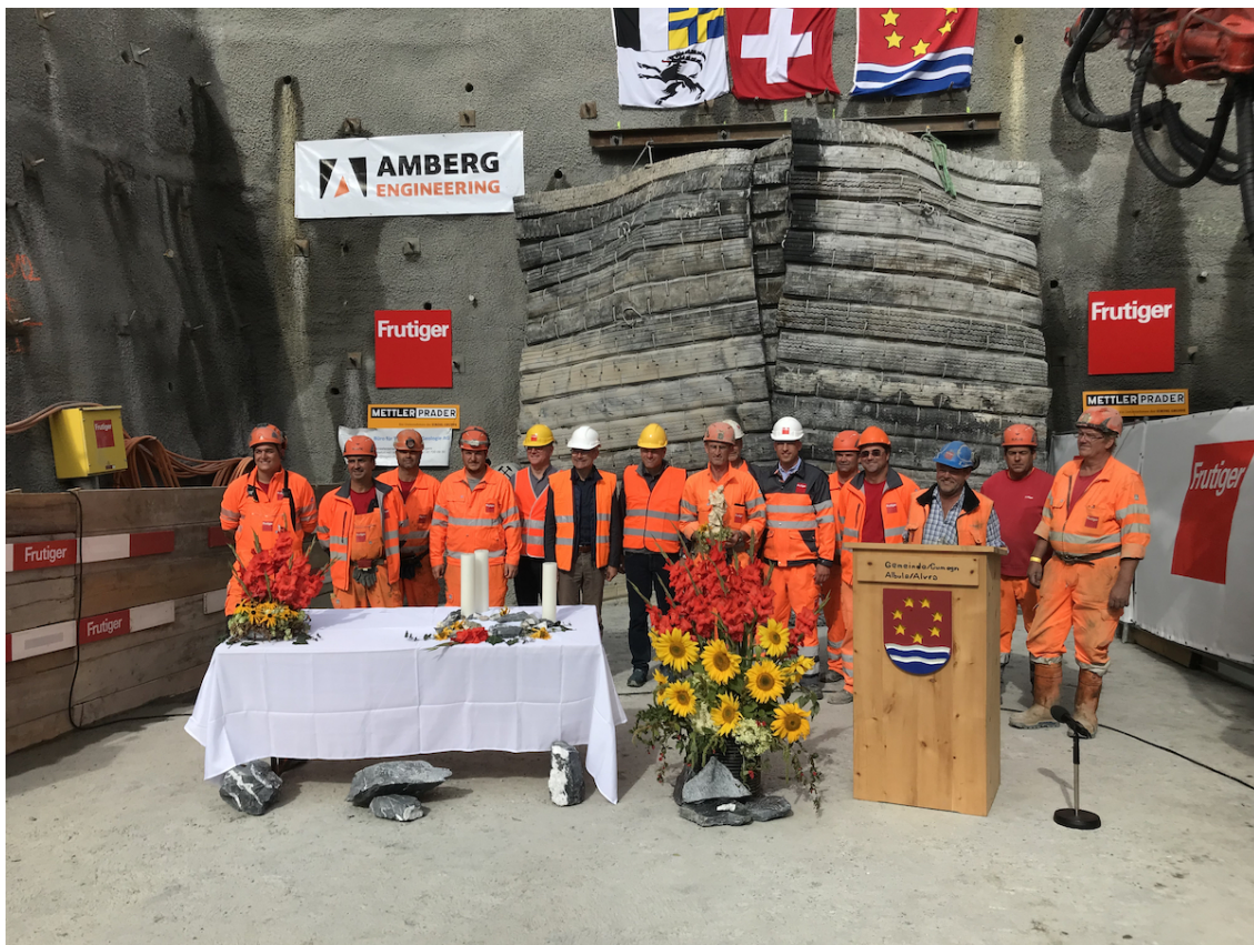
Gleich wird gesprengt: Mannschaft und die Ehrengäste am 20. September 2021 vor dem Stollenportal (Bild: gartmann.biz )
