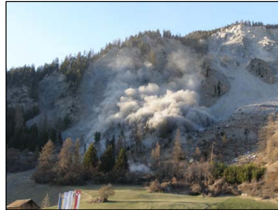
Abbruch Caltgeras (ca. 10'000 m 3 ), 2011, Tiefbauamt Graubünden
