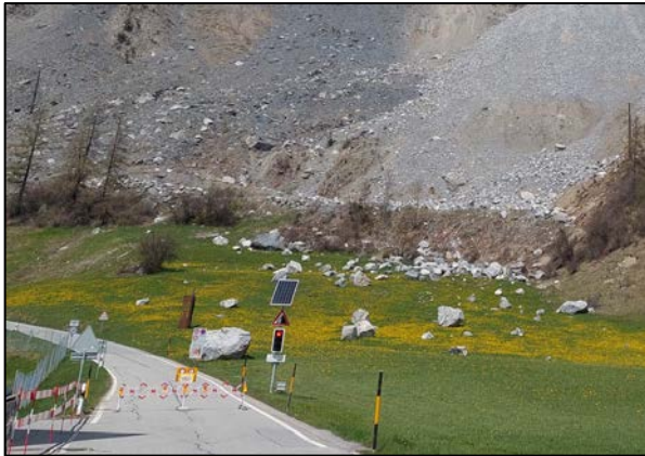
Sturzblöcke Brienz/Brinzauls (< 60 m 3 ), 2023, BTG Büro für Technische Geologie AG
