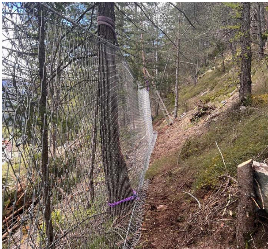
Provisorische Schutznetze am Bäumen oberhalb Surava.
