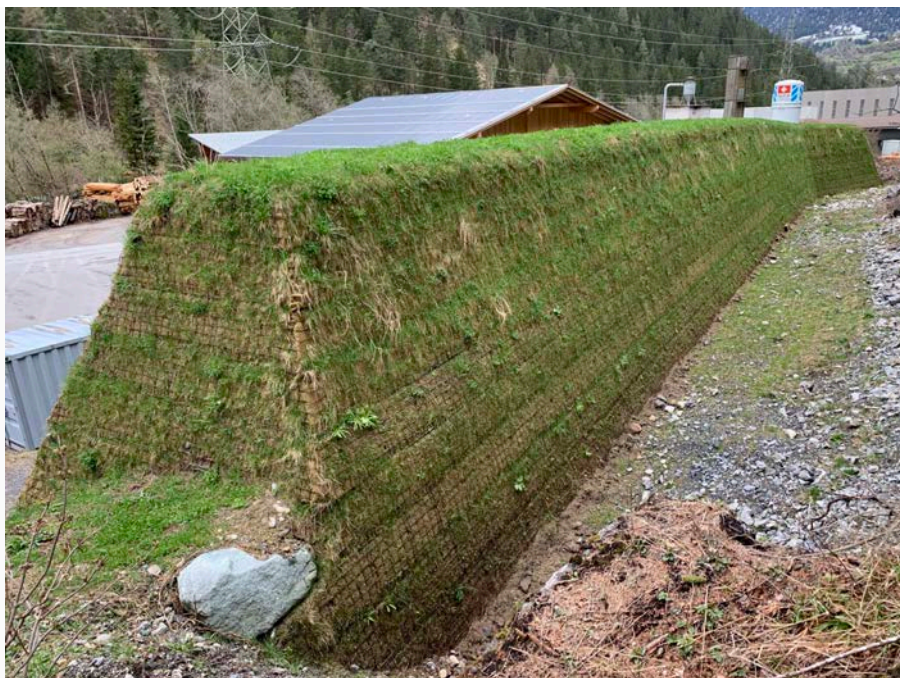
Neu erstellter Steinschlag-Schutzdamm bei Filisur.
