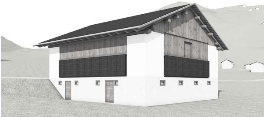
Solaranlage fassadenbündig geplant; die muralen Eckpfeiler bilden ein wichtiges Element, welche nicht durchbrochen werden dürfen
