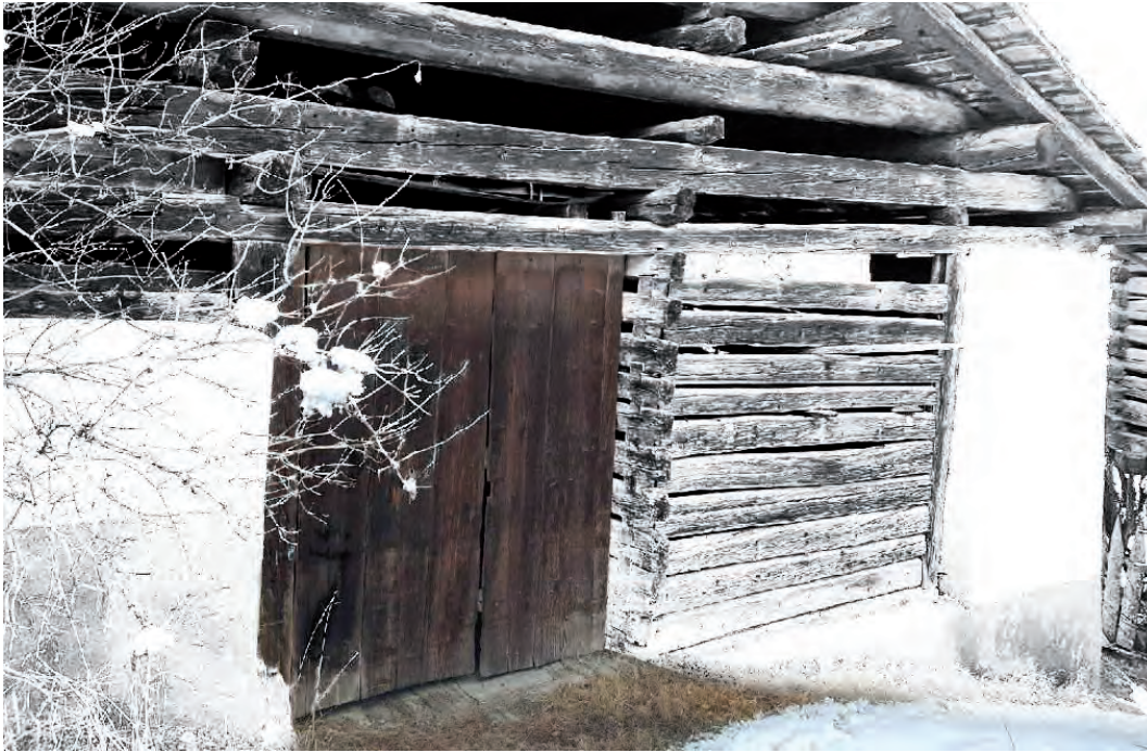
Abb. 97: Scheunentor direkt an der Strasse (Masein).
