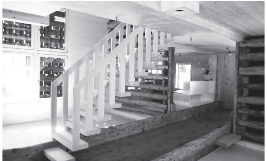
Abb. 27: Treppe im alten Tenn.
