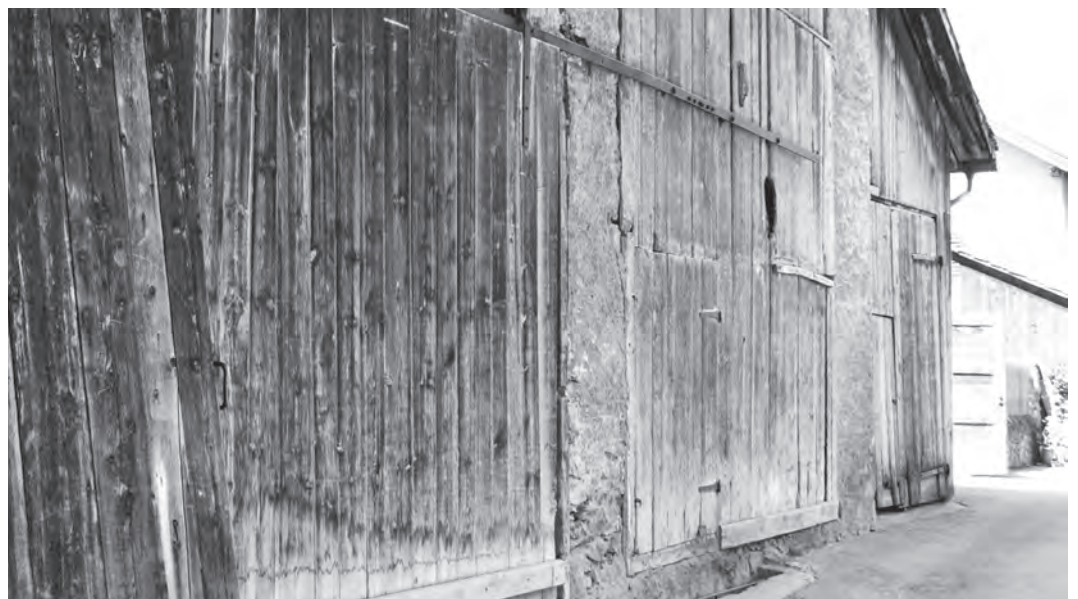
Abb. 107: Grosse Tore als Einfahrten in die Stallscheune nutzbar (z. B. Jenins).
