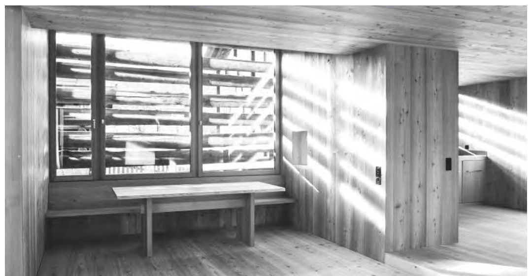
Abb. 28: Fensterscheiben hinter der gestrickten Aussenwand.
