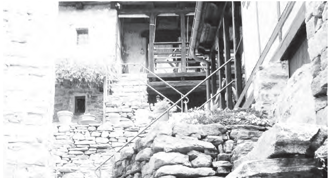
Abb. 69: Terrassen auf Zwischenpodesten und Balkonzonen hinter Gängen und Histern, im historischen Dorf Avegno.
