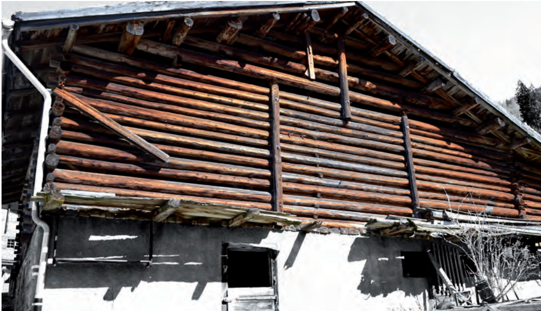
Abb. 15: Rundholzkonstruktion auf gemauertem Stallgeschoss (Curaglia).
