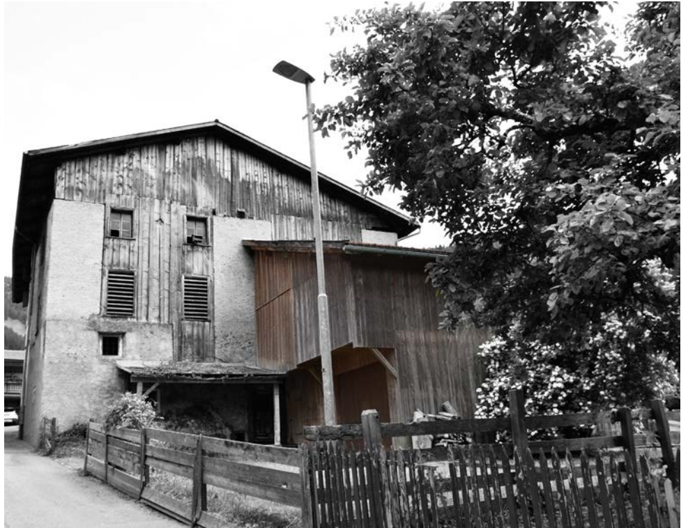
Abb. 12: Historische Stallscheune mit neuzeitlichem Anbau (Fideris)
